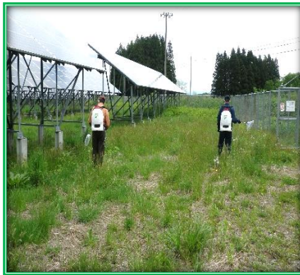
太陽光発電所除草作業
